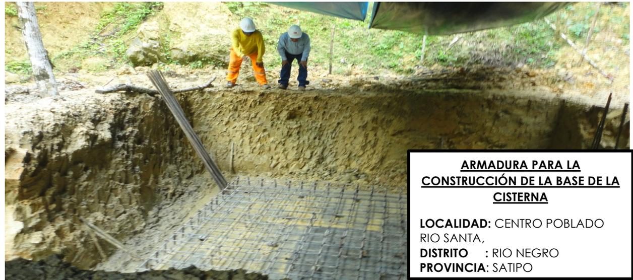
**ARMADURA PARA LA CONSTRUCCIÓN DE LA BASE DE LA CISTERNA**
