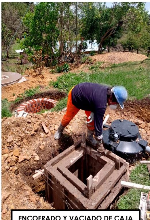
**ENCOFRADO Y VACIADO DE CAJA DE LODOS EN UBS**
