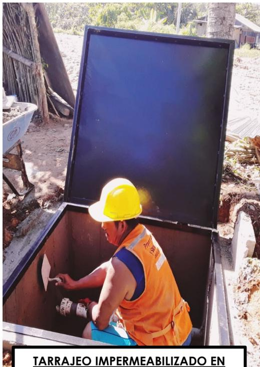
**TARRAJEO IMPERMEABILIZADO EN CAJA DE VÁLVULA DE CONTROL**
